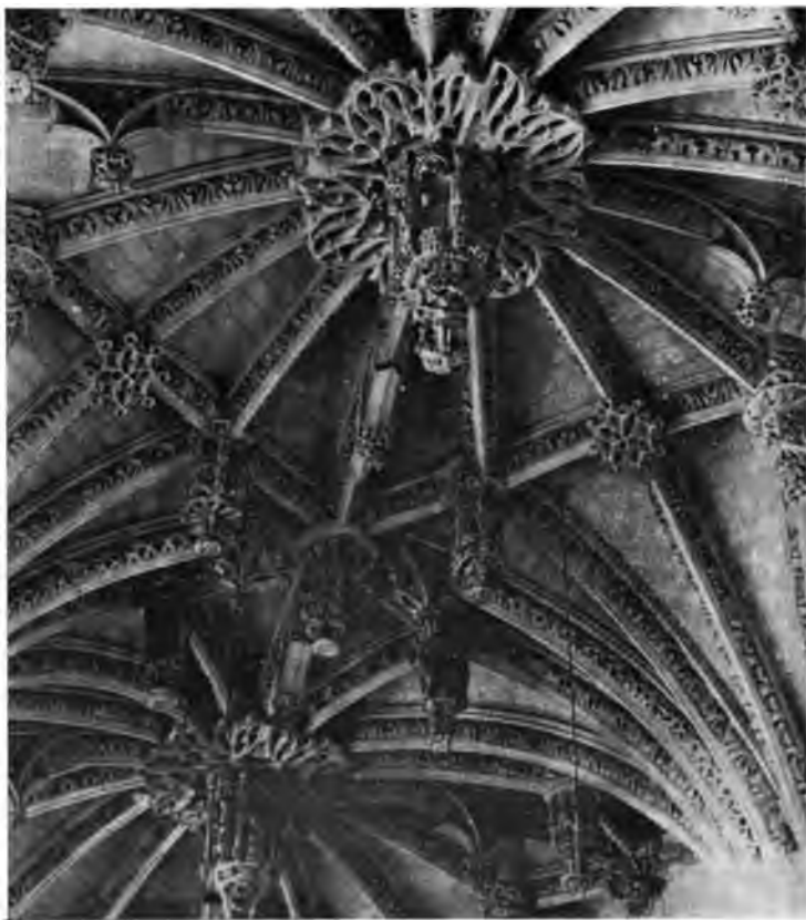
Fig. 157. — Voûte du xv e siècle formée de nervures saillantes se rencontrant sur des clefs ornées distribuées autour d'une clef centrale. Chapelle du Saint-Esprit à Rue Somme'.
